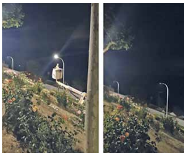
▲ Figura 9. Una misma luminaria que en laboratorio tiene FHS < 1\% puede contaminar FHS_{inst} 15% (izda.) o no (dcha.). La dirección de obra es fundamental
