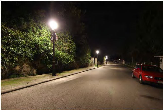
Imagen de la instalación sin difusores y óptica Type III Medium
