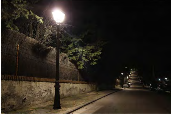
Imagen con difusores prismáticos y óptica Type II Medium
