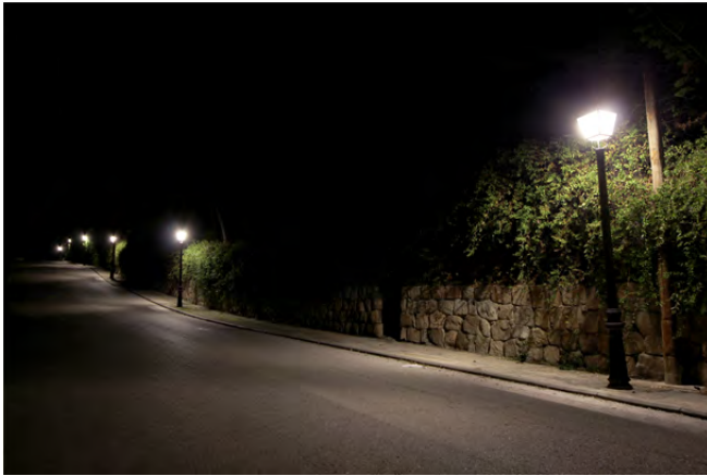
Imagen de la instalación sin difusores y óptica Type III Medium
