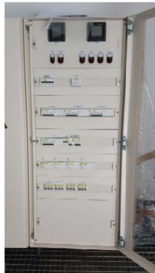
Cuadros sencillos: a la izquierda el de potencia de alumbrado, a la derecha el de telegestión
