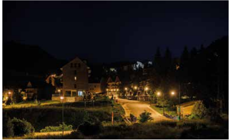
▲ Conjunto homogéneo de luminarias Pescador sobre columnas Atlas, que garantiza una imagen coherente, eficiente y respetuosa con el entorno rural pirenaico.
