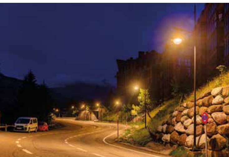
▲ Instalación en vial de montaña con ópticas personalizadas para lograr una uniformidad superior al 0,6, incluso en zonas de compleja orografía.
