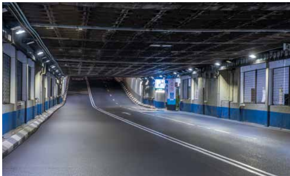
▲ Mayor seguridad y confort visual en el túnel Olavide con solo tres metros de altura.
