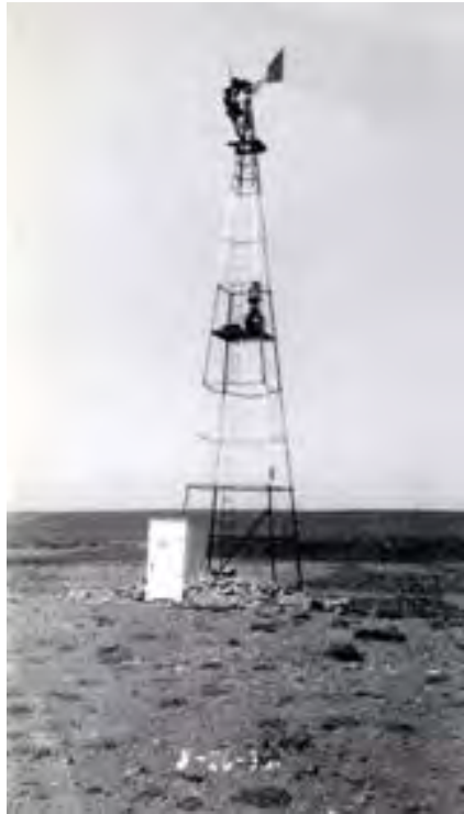
a) Aerogenerador de Aerofaro; b) Luz complementaria de aerovía. Aircraft Year Book - Ben Ashlock Steve Wolff collection.
