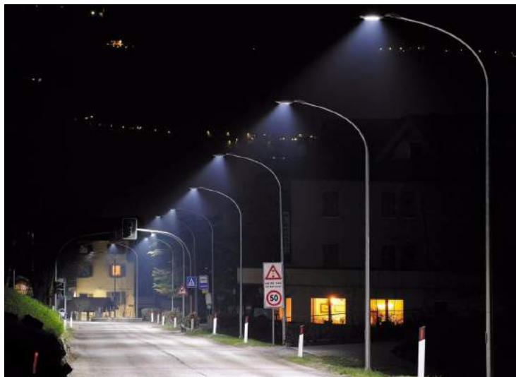
Ejemplo iluminación vial con temperaturas de color excesivamente frías
