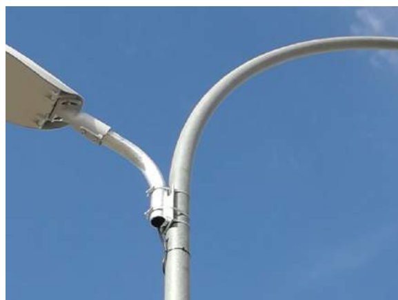
Ejemplo brazo sujeto con bridas a un báculo
