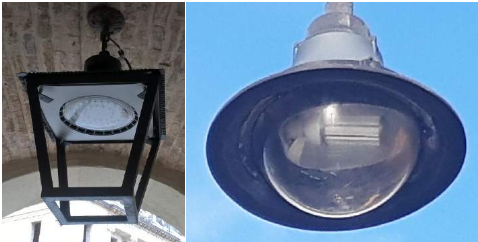
Ejemplo retrofit (Vitoria) y mazorca LED (Berrioplano, Navarra)
