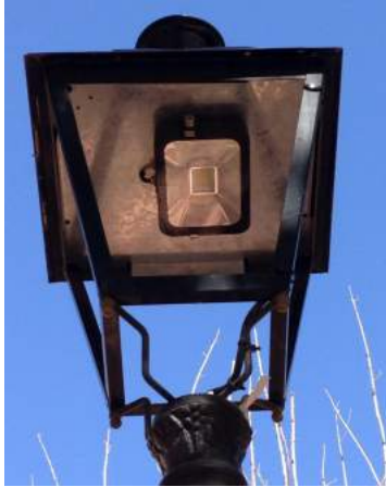
Ejemplo de proyector óptica simétrica 120° bajo rendimiento colocado sobre un farol villa y luminaria con lámpara de inducción
