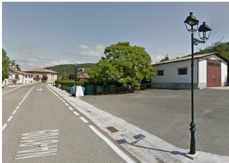
Travesía iluminada con faroles villa. El deslumbramiento TI difícilmente se cumple con luminarias a 4m.
