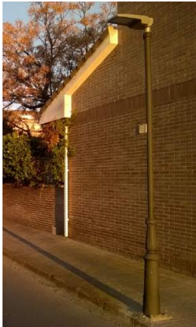
Ejemplo luminarias ambientales tipo plato color gris claro sobre columna clásica; luminaria vial sobre columna clásica 4m; y globo sobre columna vial en disposición inclinada
