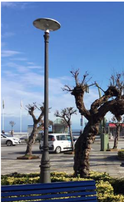
Ejemplo luminarias ambientales tipo plato color gris claro sobre columna clásica; luminaria vial sobre columna clásica 4m; y globo sobre columna vial en disposición inclinada
