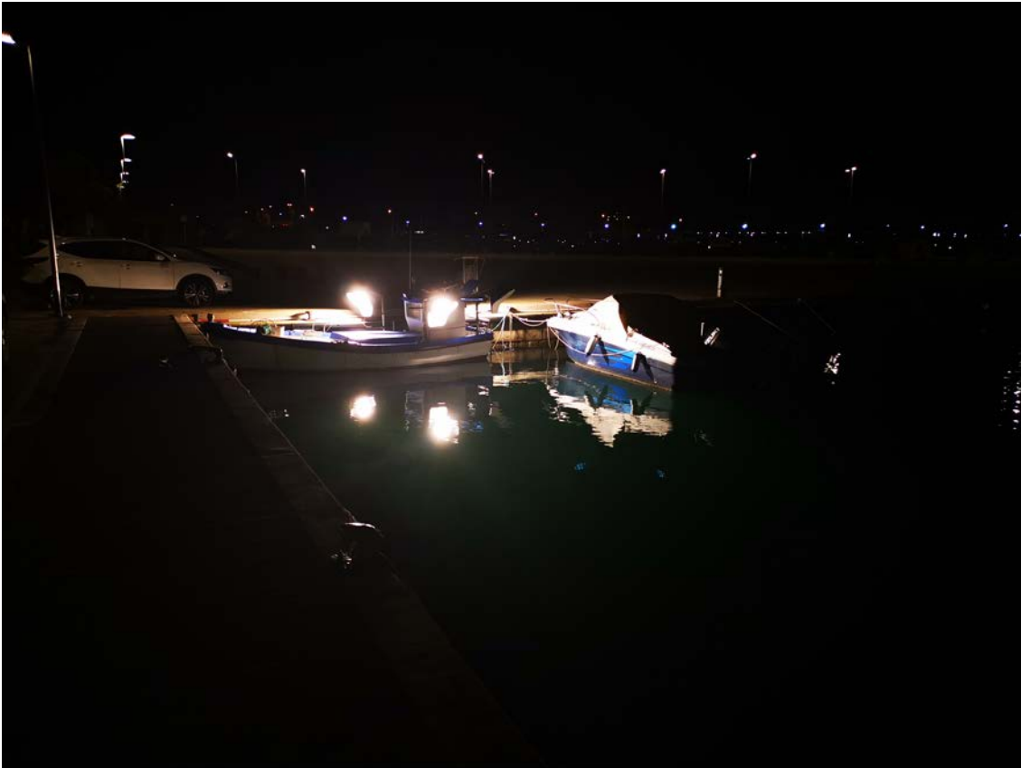
Pruebas finales con las 4 luminarias instaladas
