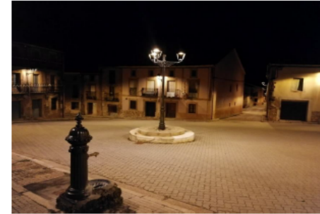
Foto de Fernando Rubio, junio 2021 Plaza Mayor, Retortillo (Soria) para S3 Villa Gen 2 de SIGNIFY 15 w 2200°k Interdistancia 16 m, anchura 3 m, altura 5 m S3 valores obtenidos con el método de 9 puntos Mínimo 5,3 lux (mayor de 1,5 lux) Media 7,6 lux (entre 6 y 9 lux) Uniformidad media 69.74 %
