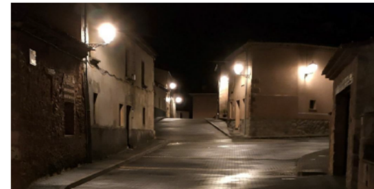
Foto de José A. Martínez, mayo 2021, Barca (Soria), para un alumbrado S3 Kit retrofit en farol villa de ATP Incluido el cerramiento opalizado, 24 w óptica A7 2.200°k Interdistancia 25 m, 4.5 altura y ancho de vial de 7 m Valores obtenidos por el método de los nueve puntos: media 8.55 lux de media (entre 6 y 9 lux) 4.19 de mínima. (mayor de 1.5 Lux) Deslumbramiento D4 (mayor de D3)
