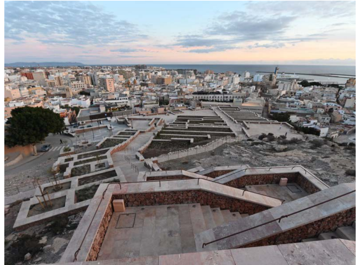
Vistas del Cerro después de su ejecución
