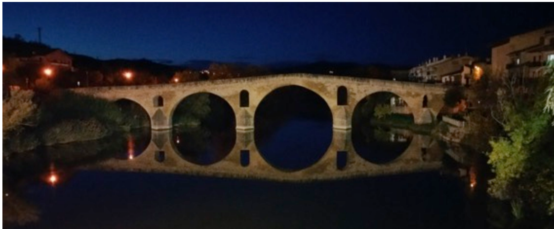
Iluminación actual del puente románico. Se observa luz intrusa en las fachadas y en el propio río
