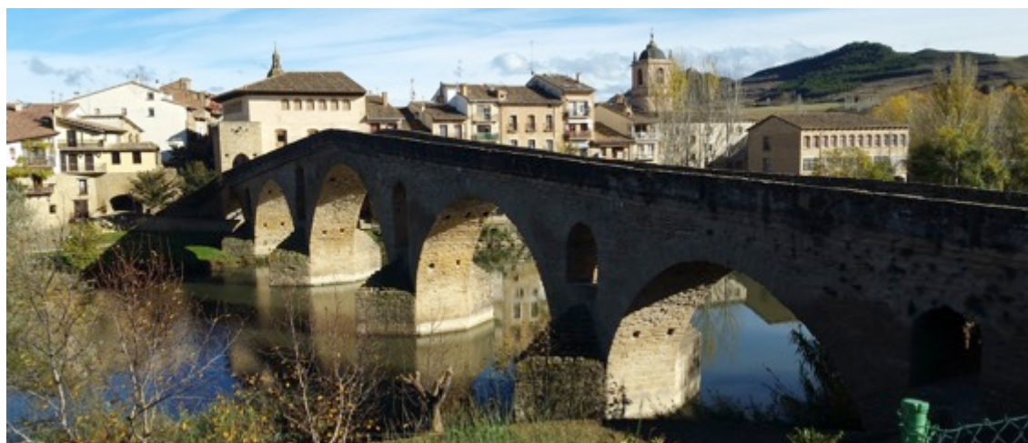
Vista actual del puente
