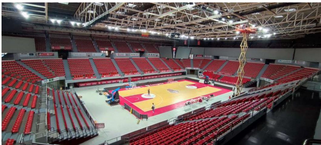
Detalle instalación en fase de apuntamiento
