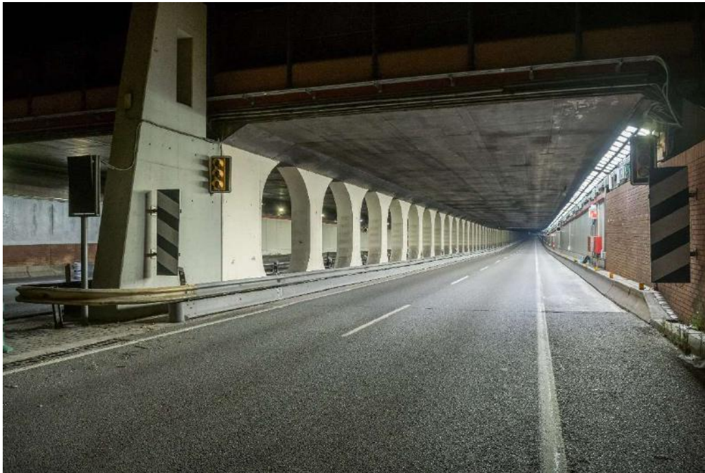
Ilustración 8. Iluminación diurna durante una de las noches de puesta en marcha de la instalación.
