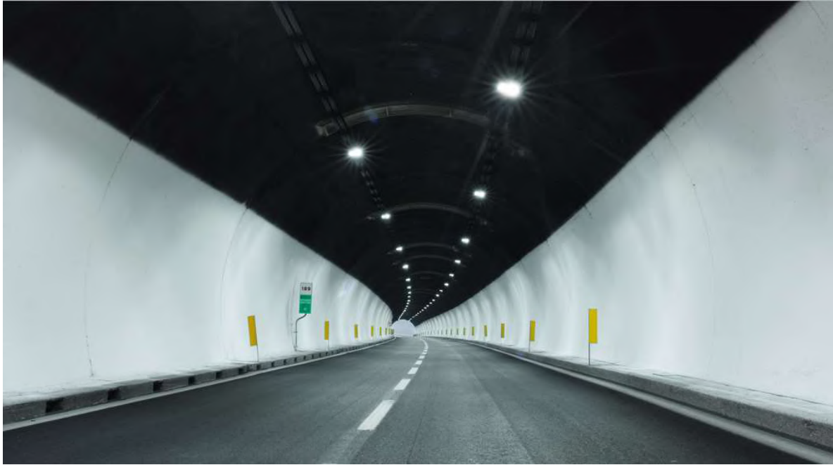
Año 2011 - Tunel Croci di Calenzano su A1 el primer túnel en Italia totalmente iluminado por LED (entrada y interior)
