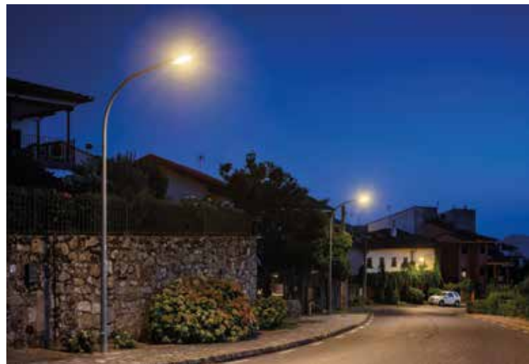
▲ Alta uniformidad en el centro de la localidad con luminarias LED de ATP.
