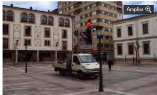
Un operario sustituye las luminarias LED en la plaza Camila Beceña.
