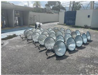
Desmontaje de más de 300 proyectores
