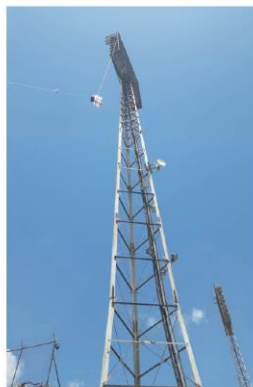
Montaje de los 120 proyectores LED
