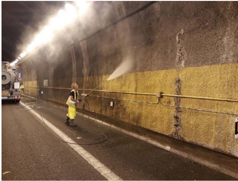
Imagen 11.- Hidrolimpieza de hastiales del tubo sentido Valencia.
