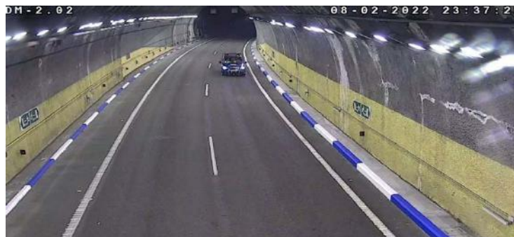
Imagen 1.- Mediciones dinámicas de la iluminación en el túnel de l'Ollería con el vehículo ILLUMETRIC.
