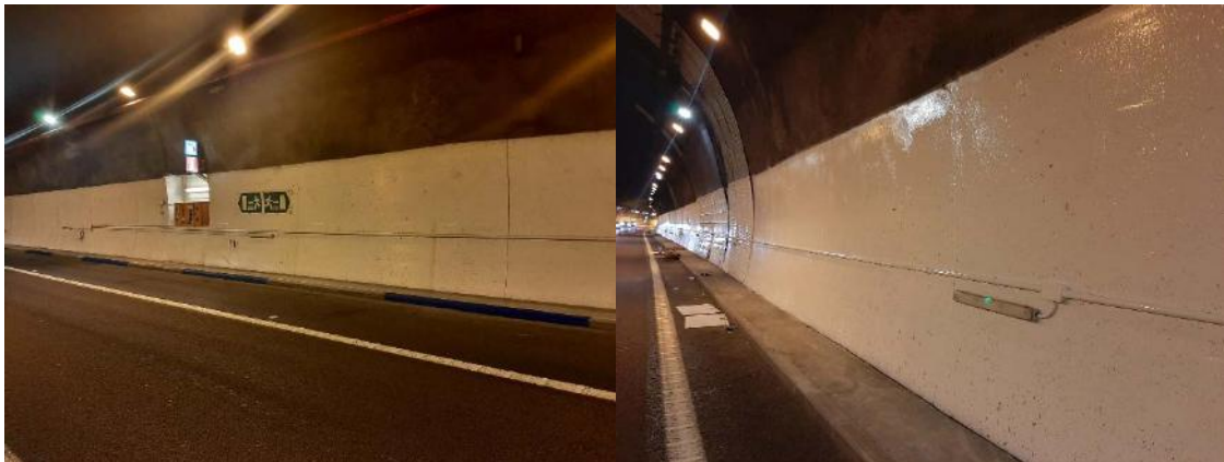
Imagen 10.- Pintura de hastiales del tubo sentido Alicante.
