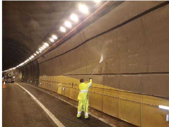
Imagen 9.- Hidrolimpieza de hastiales del tubo sentido Alicante.
